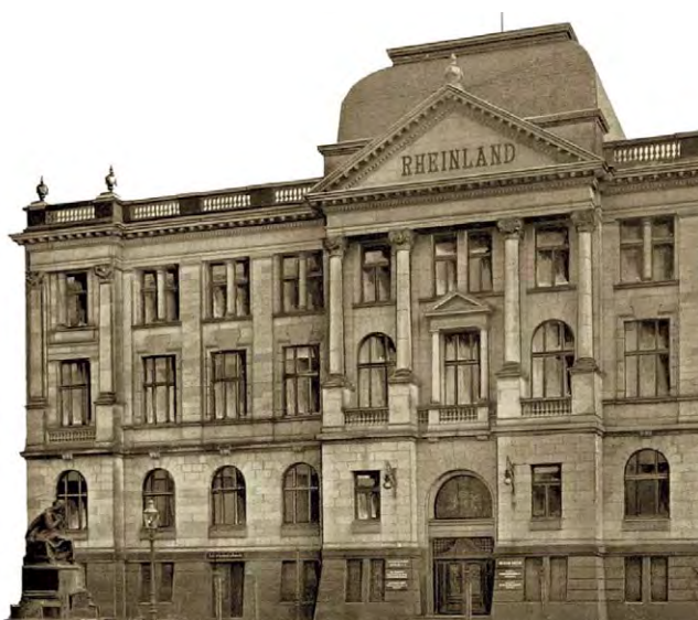
Abb. 43: Neusser Rheinlandgebäude vor dem Umbau
