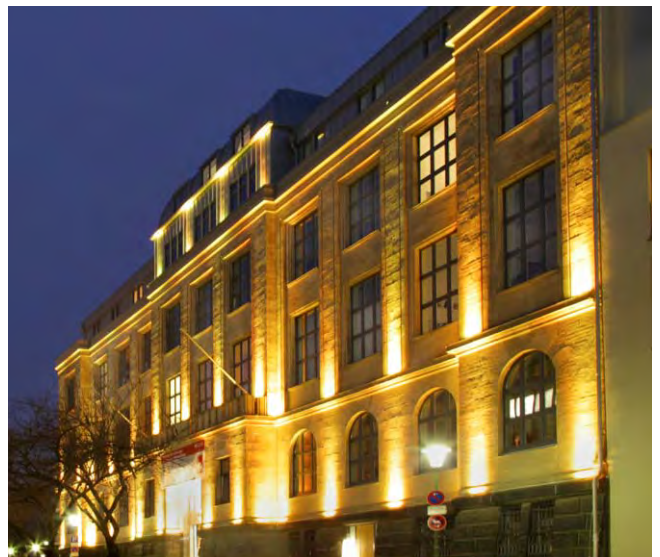
Abb. 44: Neusser Rheinlandgebäude nach dem Umbau
