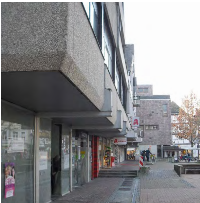
Abb. 116: Erdgeschosszone Marktquartier vor dem Umbau
