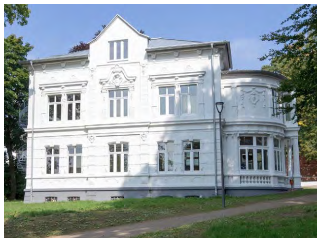
Abb. 128: Villa Wippermann in Halver nach der Sanierung
