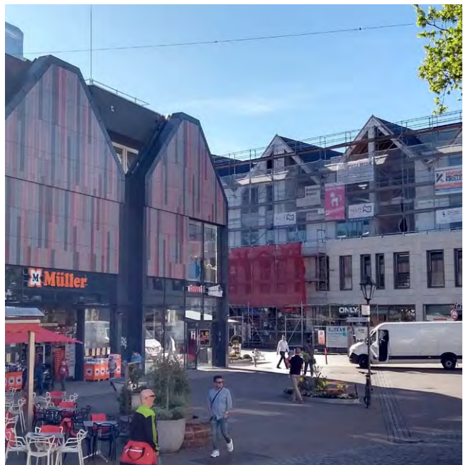
Abb. 117: Ensemble „Markt 1“ und Marktquartier (im Bau)
