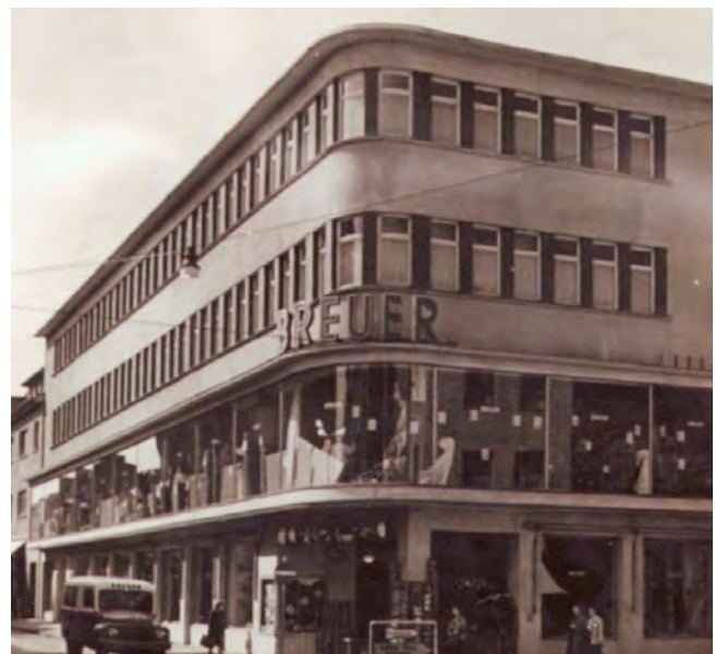
Abb. 46: Eschweiler Kaufhaus Breuer vor dem Umbau
