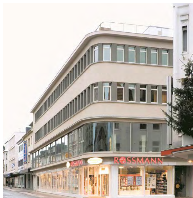
Abb. 47: Eschweiler Kaufhaus Breuer nach dem Umbau
