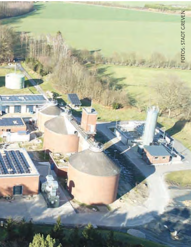
Seit 2010 wurden sukzessive alle Dachflächen mit Photovoltaik ausgerüstet
